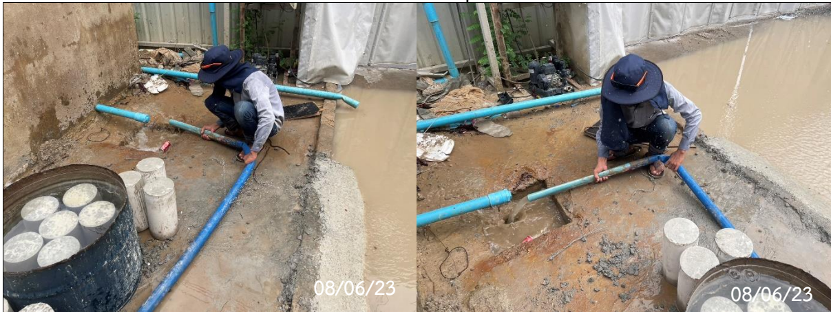
รูปที่ 2-37 การขุดลอกตะกอนดินบริเวณบ่อพักตะกอนดิน
