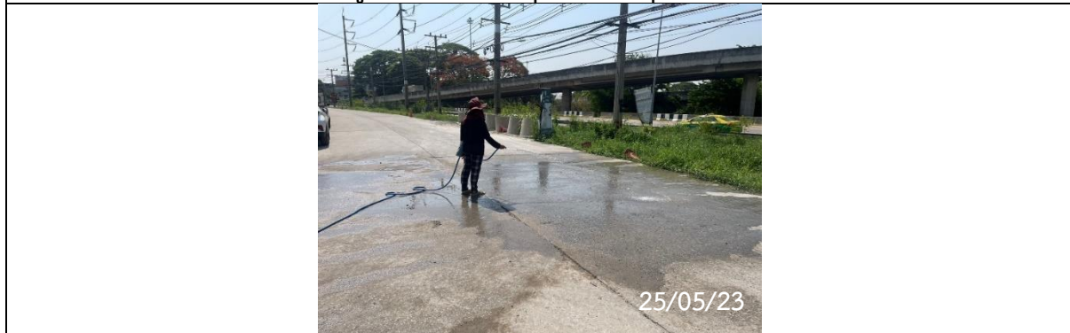
รูปที่ 2-6 การฉีดพรมน้ำบริเวณพื้นที่ก่อสร้าง
